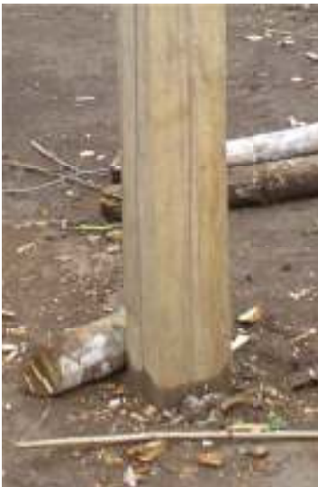
Abbildung 24: Bauteil mit Bodenkontakt
