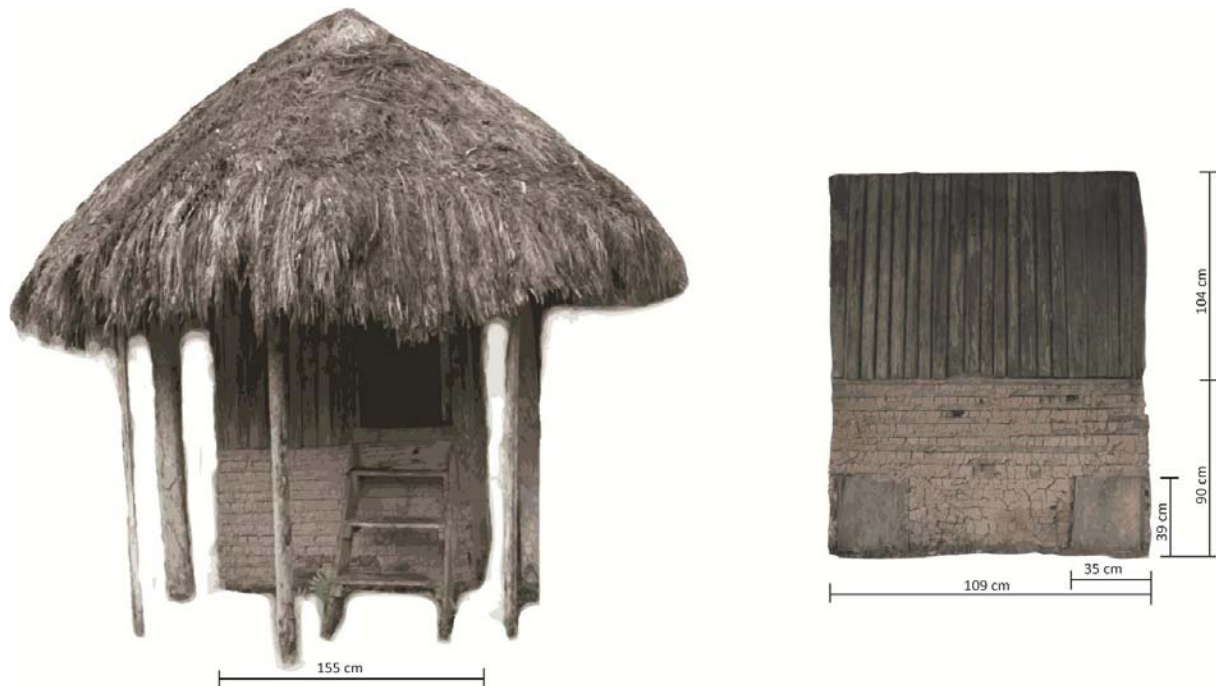
Abbildung 13: Trocknungstoilette des Sanitätshauses mit Maßangaben
