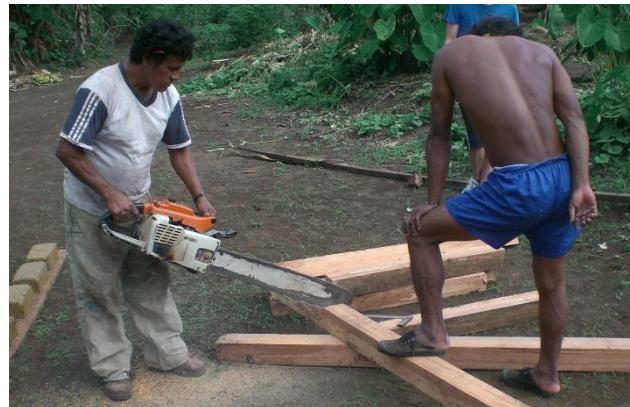
Abbildung 22: Herstellung einer Verbindung
