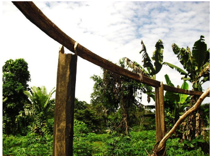
Abbildung 18: Fixierung von Dachbalken
