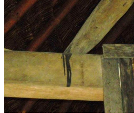
Abbildung 20: Schädlingschutz mit Teer und Benzin
